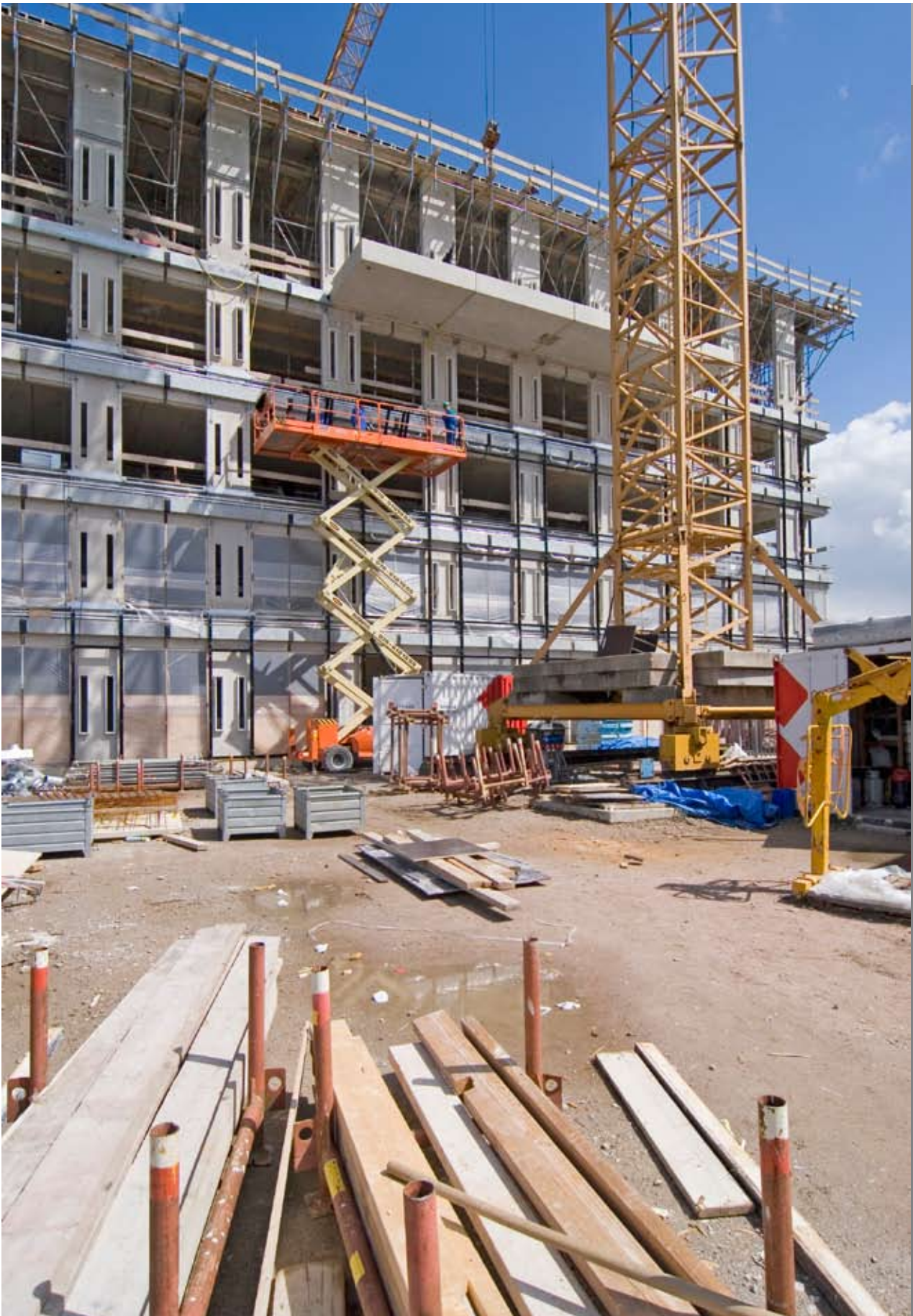
De ruwbouw is op hoogte, gevelbouwer ZNS Van Dam Geveltechniek werkt vanaf eigen hefsteigers aan de montage van de hoogwaardige gevels
