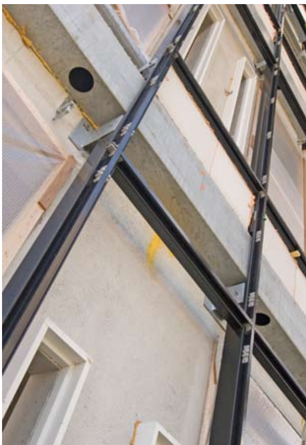
Aluminium kader voor bevestiging van de donkere gevelpanelen is al deels aangebracht, voordat deze achterconstructie kon worden aangebracht, heeft ZNS Van Dam Geveltechniek vooraf de ankerplannen uitgetekend en de montageankers uitgelijnd met laserapparatuur. De ankers zijn door ZNS Van Dam Geveltechniek zelf ontwikkeld
