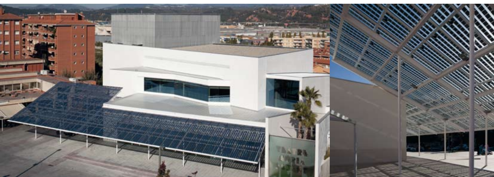
Facciata continua con pannelli fotovoltaici - Teatro Municipal Nuria Espert - Sant Andreu de la Barca, Spagna (Architetto : EPG Estudios y Proyectos Grau SL)
