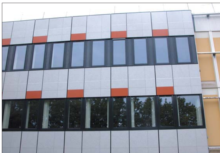
Vue extérieure, après mise en place des châssis et des parements
