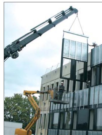
Élévation des ensembles
