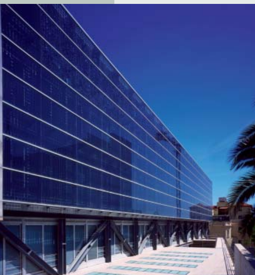
Vorhangwand mit Photovoltaikpaneelen - La Salle - Barcelona, Spanien (Architekt: Robert y Esteve Terradas Muntanola)
