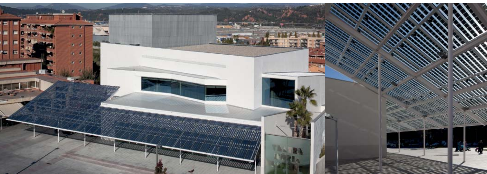
Fassadendach-Anwendung mit Photovoltaik Paneelen - Teatro Municipal Nuria Espert - Sant Andreu de la Barca, Spain (Architekt : EPG Estudios y Proyectos Grau SL)
