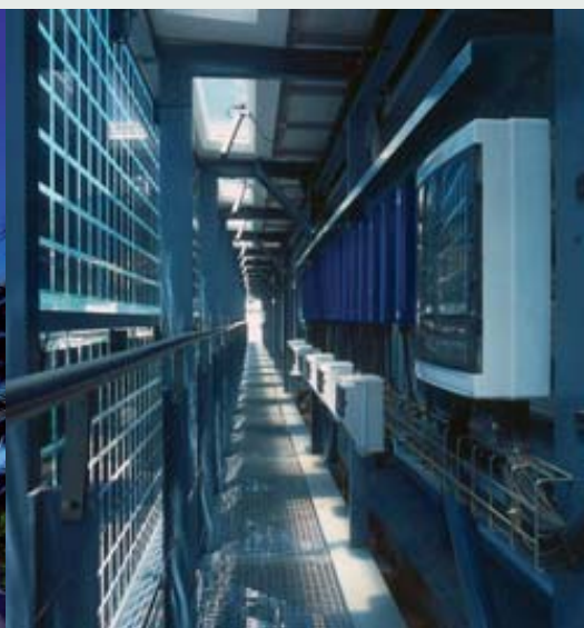
Vorhangwand mit Photovoltaikpaneelen - La Salle - Barcelona, Spanien (Architekt: Robert y Esteve Terradas Muntanola)
