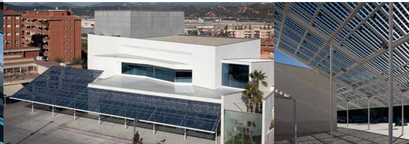
Curtain wall roof application with photovoltaic panels - Teatro Municipal Nuria Espert - Sant Andreu de la Barca, Spain (Architect : EPG Estudios y Proyectos Grau SL)
