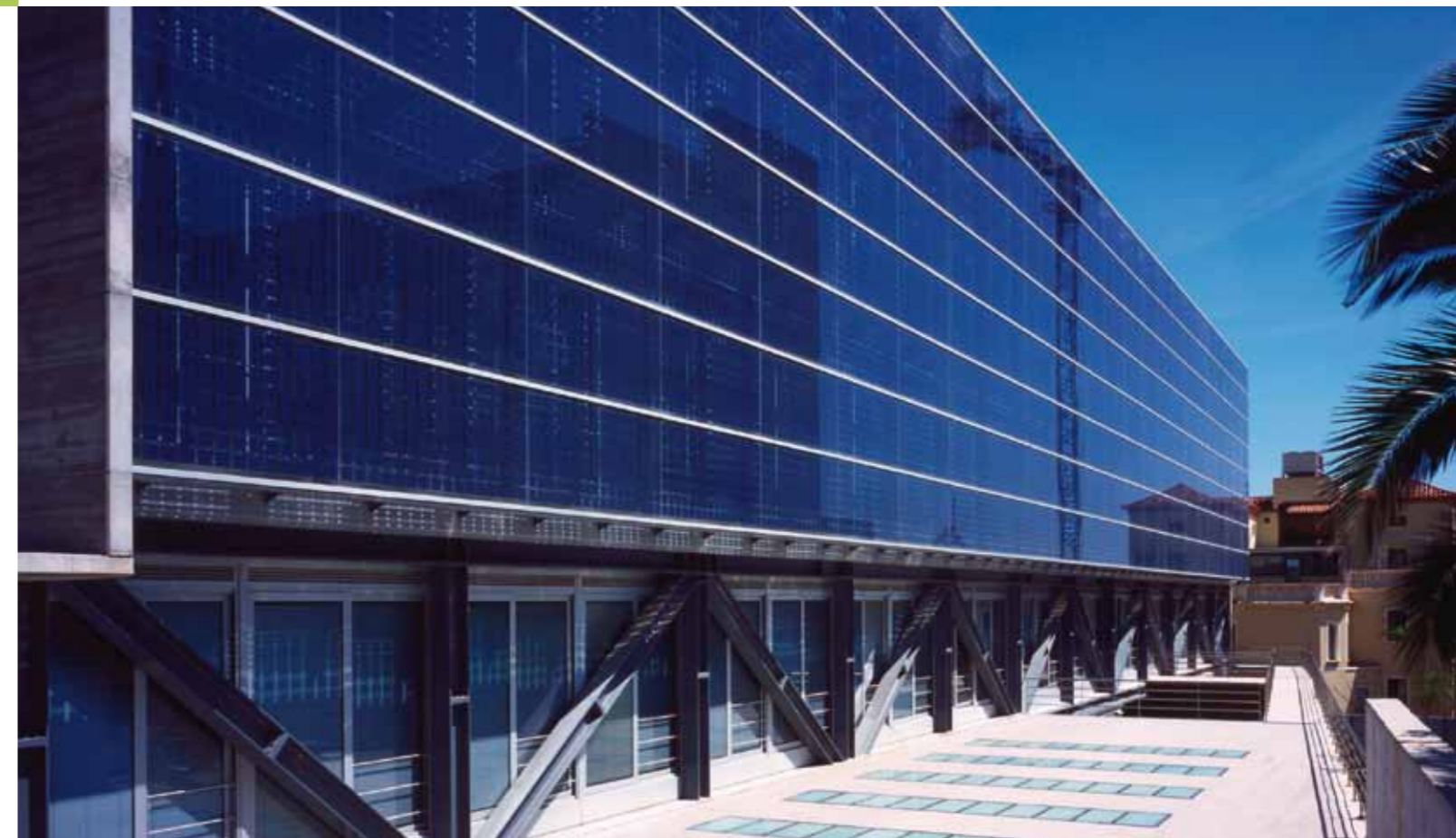
La Salle - Barcelona, Spain (Architect : Robert y Esteve Terradas Muntañola)
